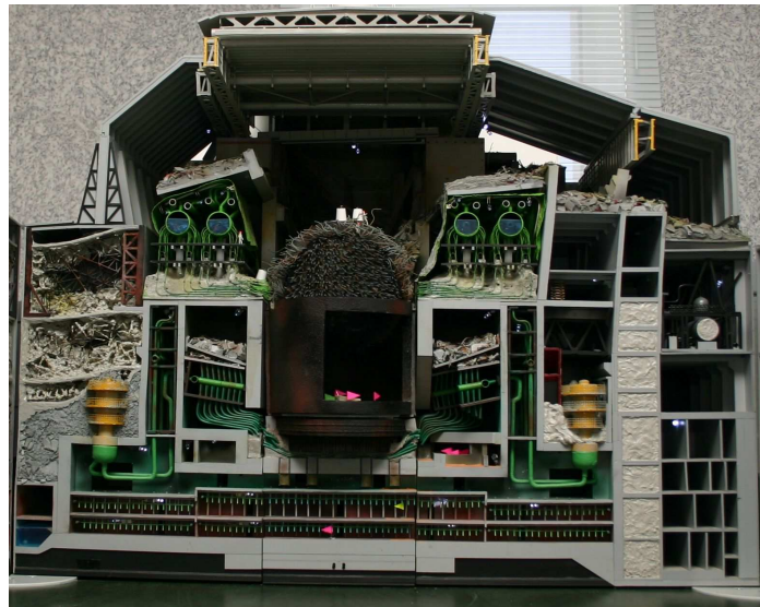
3. ábra. A szarkofág makettje (Fotó: Dr. Aszódi Attila) (Középen a reaktor, rajta a hatalmas, ferdén álló reaktorfedél. Jól látható, hogy a mentési munkálatok során betöltött anyagok és a robbanásban keletkezett törmelékek hogyan töltik ki az egyes helyiségeket)
